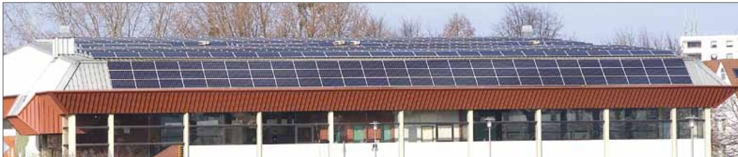
**Auf dem Dach der Sporthalle in Ochtersum hat die EVI Energieversorgung Hildesheim eine Fotovoltaikanlage installiert. Mit einer Fläche von 1840 Quadratmetern und 500 Sonnenkollektoren ist es die größte Anlage in Ochtersum, mit der Strom ins Netz eingespeist wird. Über 100 000 kWh Strom sollen hier jährlich erzeugt werden.**
