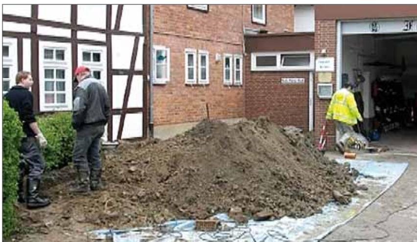
Dieser Aushub war nicht vorgesehen, aber zur Verlegung neuer Abwasserleitungen waren Tiefbauarbeiten nötig.
